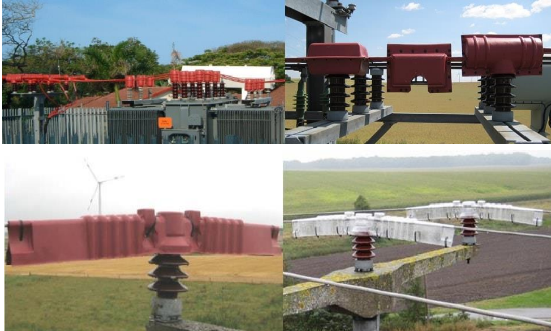
شکل (۱-۴۲) نمونه‌هایی از راهکارهای مقابله با وقوع خطای زمین توسط پرنده‌های با جثه متوسط [۳۵]
