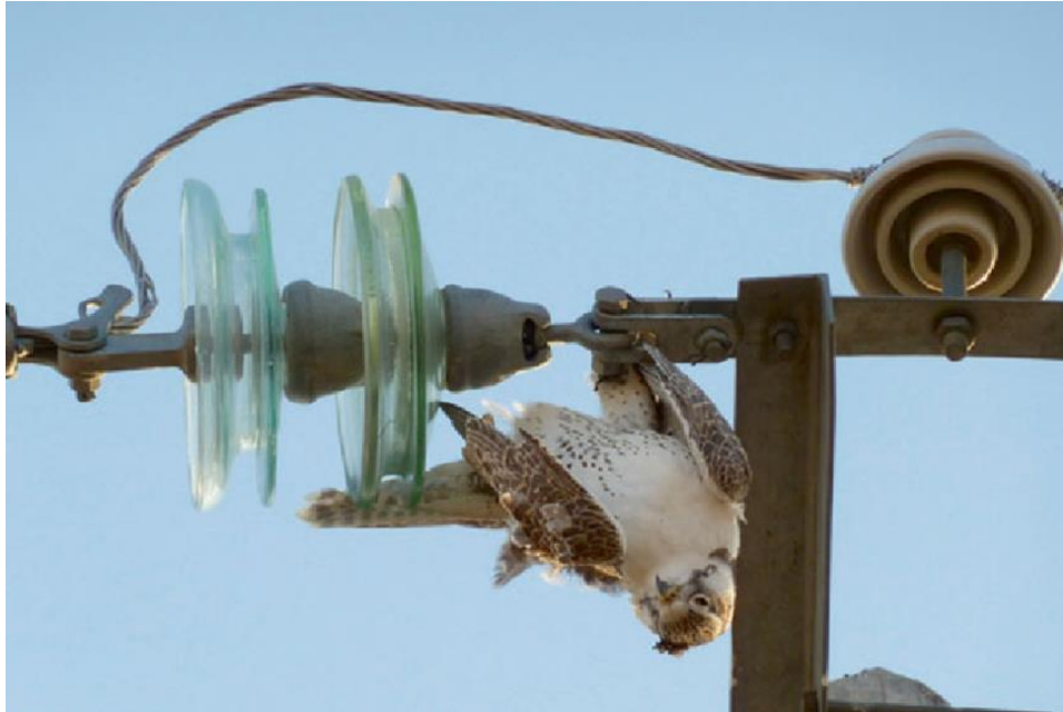
شکل (۱-۳۹) تصویری از یک نمونه پرنده‌زدگی خطای زمین
